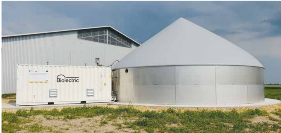
Jedna z 30 mikrobiogazowni o mocy 33 kWe pracująca przy gospodarstwie rolnym
